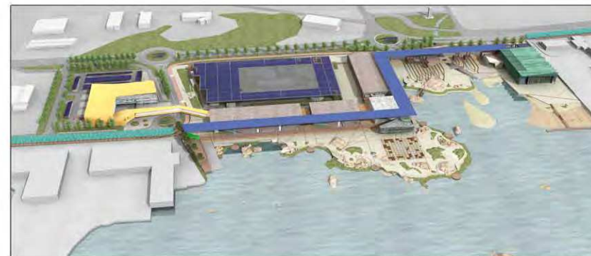
Visione aerea del complesso
